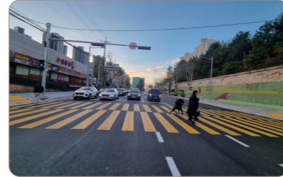
주감초 육교철거 후 횡단보도 설치
